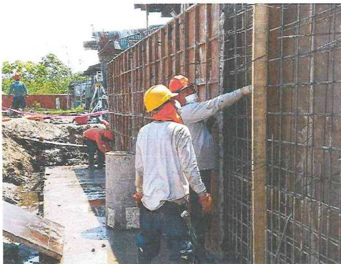
SE VISUALIZA ENCOFRADO DE MURO DE CONTENCION EN (PASAJE LOS ROSALES)
