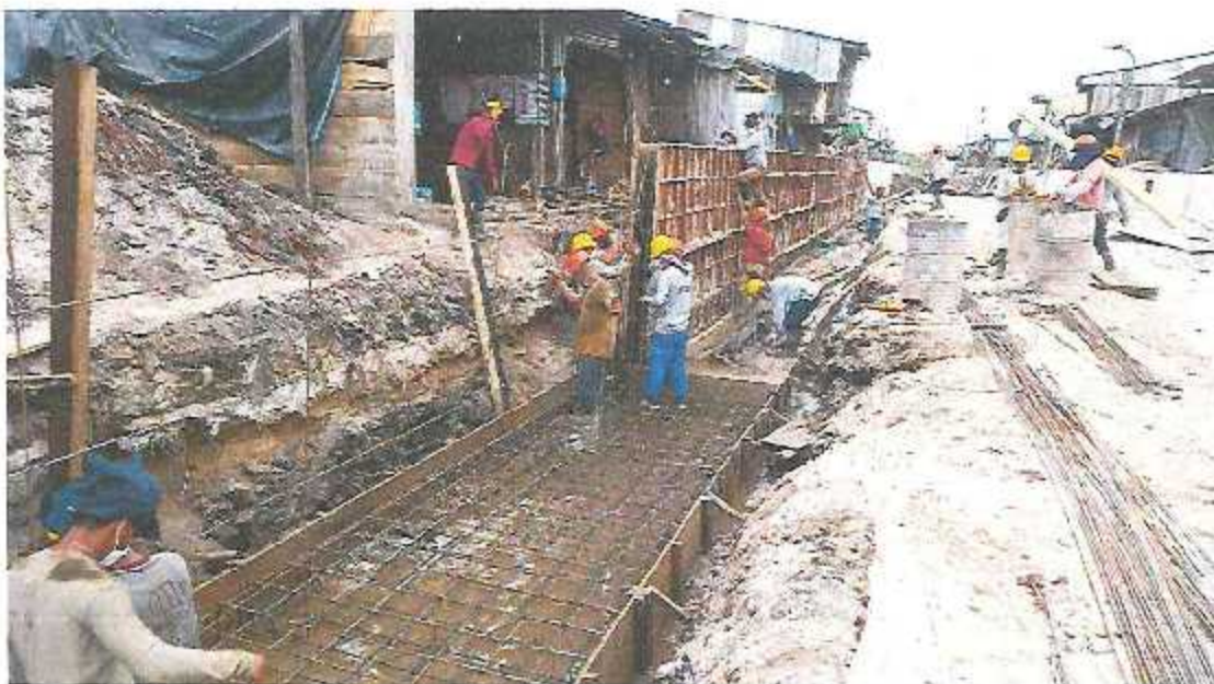
SE VISUALIZA COLOCACION DE ARMADURA DE ACERO DE MURO DE CONTENCION EN (CALLE 17 DE JUNIO)
