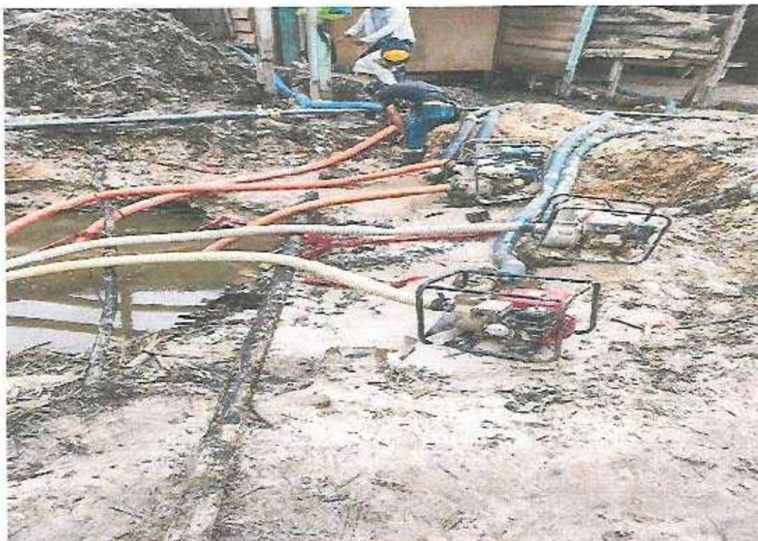
SE VISUALIZA ELIMINACION DE AGUA POR LUVIA PARA FACILITAR LOS TRABAJOS PROGRAMADOS EN (PASAJE LOS ROSALES)
