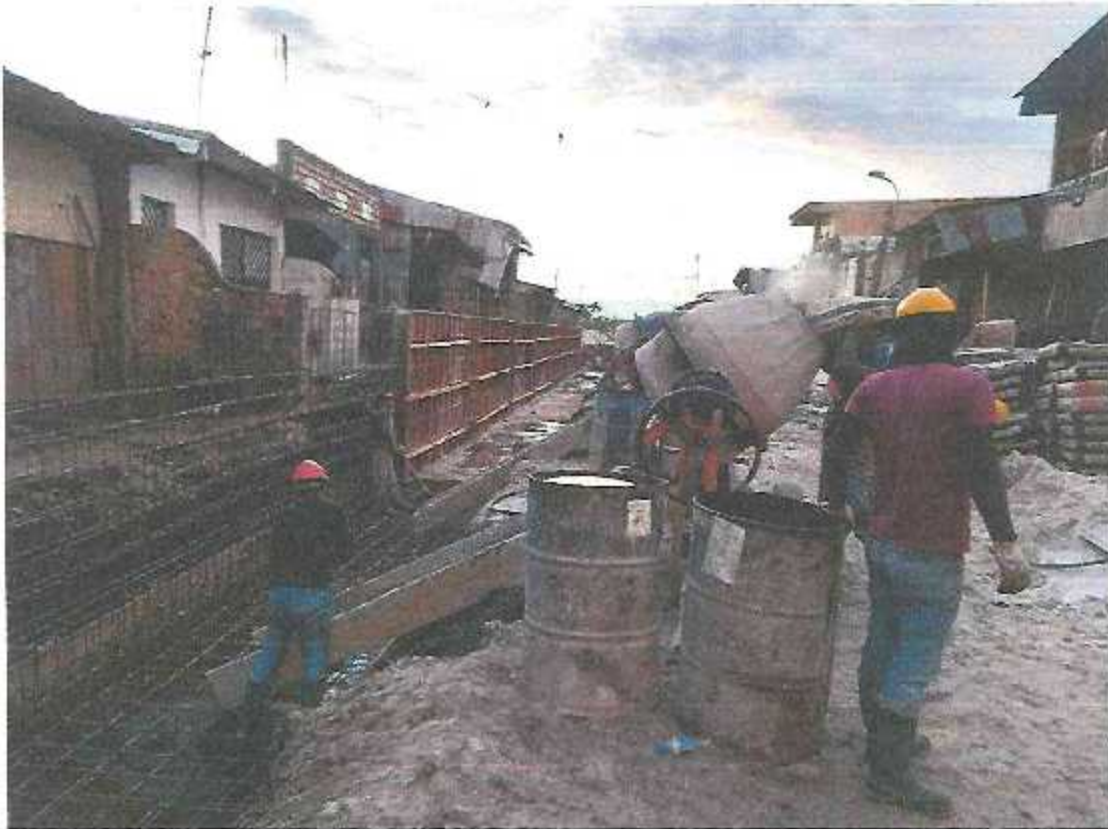
SE VISUALIZA COLOCACION DE ARMADURA DE ACERO DE MURO DE CONTENCION EN (CALLE 17 DE JUNIO)
