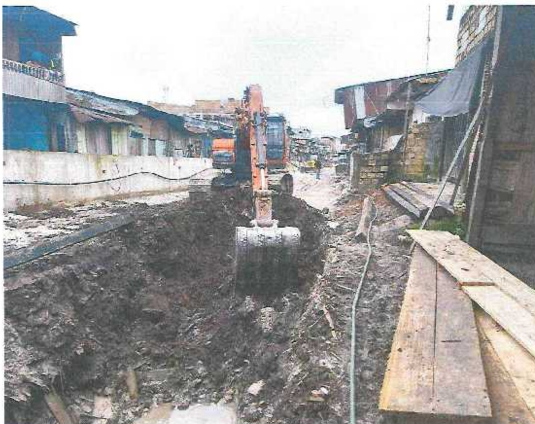
SE VISUALIZA EXCAVACION DE ZANJA PARA ZAPATA DE MURO DE CONTENCION EN (CALLE 17 DE JUNIO)
